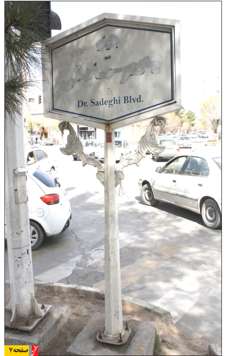
مخدوش کردن تابلو نامگذاری خیابان
