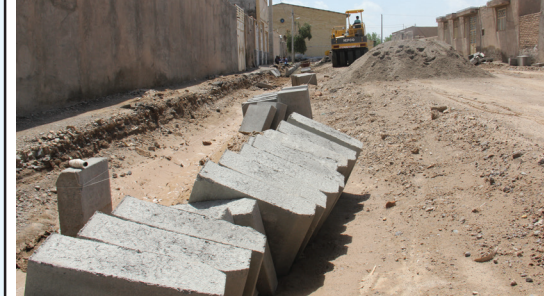
اقدامات انجام شده: اجرای جدول و کانیو بفل ۲ کوچه واقع در خیابان میروازضا به مترز ۳۰۰ متر - اجرای جدول و کانیو بفل کوچه واقع در خیابان موسی بن جعفر حدود ۷۰۰ متر - کوچه هجرت ۳۱ - کوچه پشت دانشگاه پیام نور - کوچه واقع در شهرک فدک - خیابان سپاس
