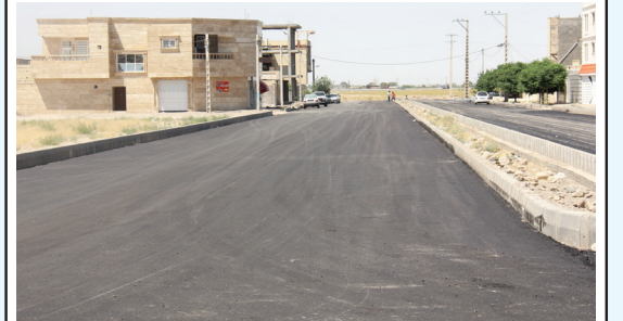
اقدامات انجام شده: تجهیز کارگاه - جدولگذاری بلوار دریا ، میدان صدف ، بلوار ساحل ، بلوار موج - خیابان پشت پمپ بنزین - کوچه ۱۲ متری - تحویل موقت
