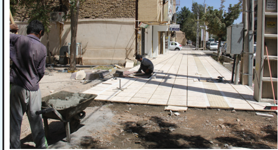
اقدامات انجام شده: اجرای جدولگذاری لاین شمالی بلوار فاطمیه از تقاطع بلوار نماز تا فرمانداری اجرای جدولگذاری لاین غربی بلوا مالک اشتر از تقاطع سیداحمد خمینی تا تقاطع صفارزاده لاین شمالی خیابان شریعتی حد فاصل چهارراه سیاه تا میدان انقلاب - لاین شرقی و غربی تقاطع فرمانداری تا تقاطع مالک اشتر - عرضی جلو فرمانداری و سه تقاطع عرضی خیابان مالک اشتر دور تا دور پارک بنفشه - دال عرضی تقاطع مالک اشتر و صفارزاده
