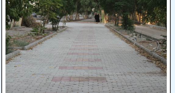
اقدامات انجام شده: اجرای کف پوش بتنی پیاده رو بلوار قائم ۸۰۰۰ متر مربع خیابان صائب ۳۰۰۰ مترمربع - خیابان دهخدا ۲۵۰۰ مترمربع خیابان شهید محمدی جنب مسجد فاطمیه ۲۰۰ متر مربع
